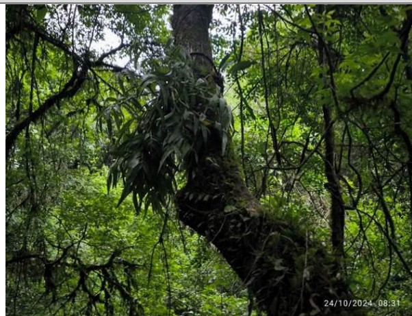
Fotografía N° 33: Área de construcción de camino de acceso a la planchada del Pozo DMO-X3. Obsérvese bosque húmedo subandino Boliviano - Tucumano.
