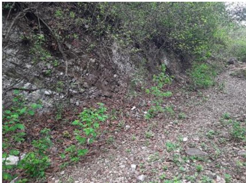
Figura 2-45: Ejemplo de erosión por deslizamiento traslacional
