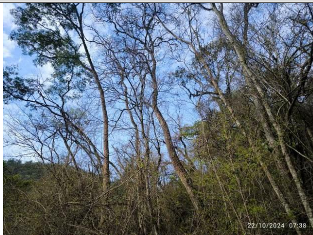
Fotografía N° 34: Área de construcción de camino de acceso a la planchada del Pozo DMO-X3. Observese Bosques subhúmedos Boliviano-Tucumanos del subandino superior.
